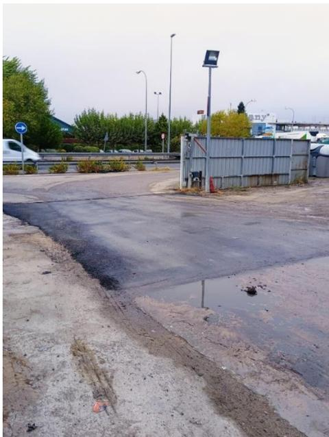
Por otro lado, se ha sustituido uno de los báculos de la campa principal, en concreto el que se situaba entre el terrizo y el depósito de combustible. Se ha aprovechado para instalar un báculo con una cruz de dos pantallas LED, con mayor índice de lúmenes, para dotar de mayor iluminación a las instalaciones.
