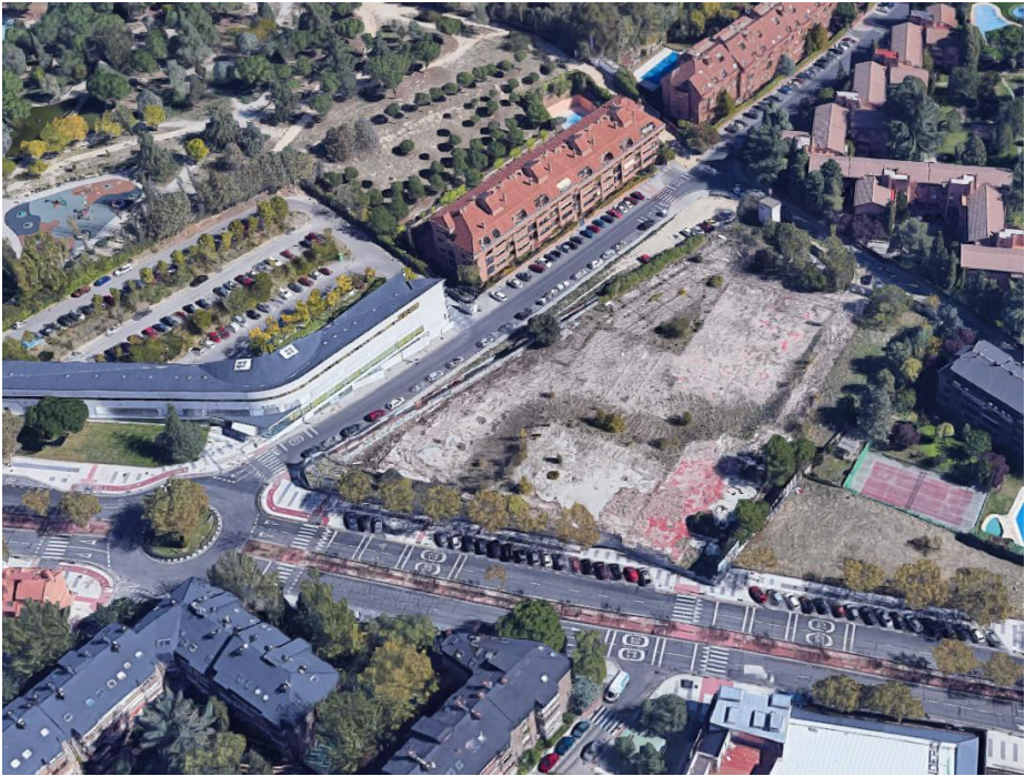
-Estado actual terrenos "Nortron"-
